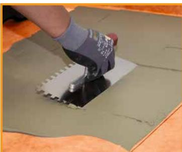
**7** Die nachfolgende Fliesenverlegung kann ohne lange Wartezeit direkt auf der Racofix® RF-100 Flex-Dichtbahn erfolgen. Hierzu mit der Kelle unter Druck eine Kontaktschicht, ...
