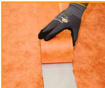
**5** Racofix® RF-100 Flex-Dichtband in das vorbereitete Kleberbett einlegen und mit der Kelle andrücken.
