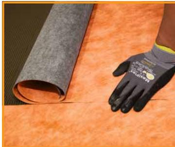
**2** Racofix® RF-100 Flex-Dichtbahn vor der Hautbildung in das frische Kleberbett einlegen und andrücken. Die Verlegung der Bahnen erfolgt bündig nebeneinander (Stoß an Stoß).
