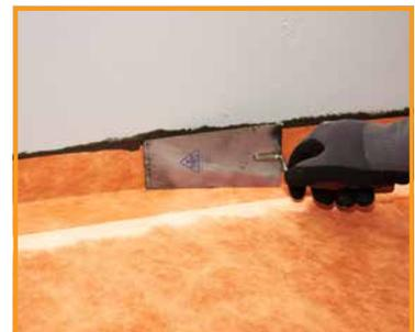
**6** Im Sockelbereich Racofix® Multi-Flexkleber schnell aufbringen, im Grenzbereich zwischen Flexkleber und Flex-Dichtbahn Racofix® Universal-Montagekleber oder Racofix® WaterBlock aufziehen. Flex-Dichtband einlegen und gut andrücken.
