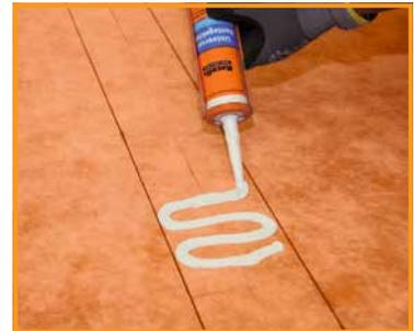
**3** Racofix® Universal-Montagekleber oder Racofix® WaterBlock im Stoßbereich auftragen.
