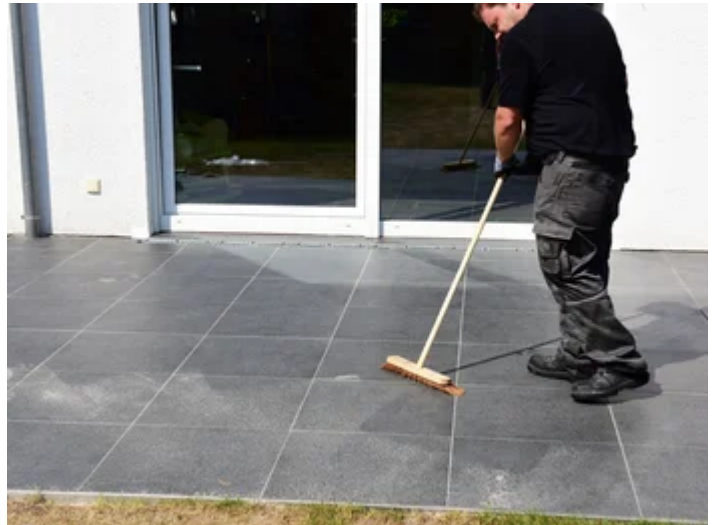
... und Mörtelreste ggf. abkehren.
