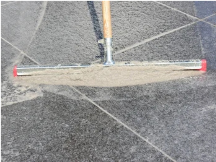
... und mittels Gummischieber in die Fuge einbringen.
