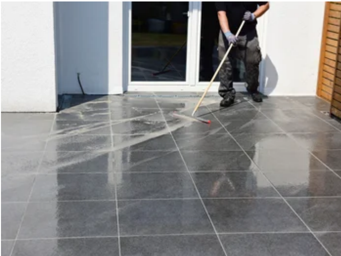
Überschüssigen Fugenmörtel abtragen ...
