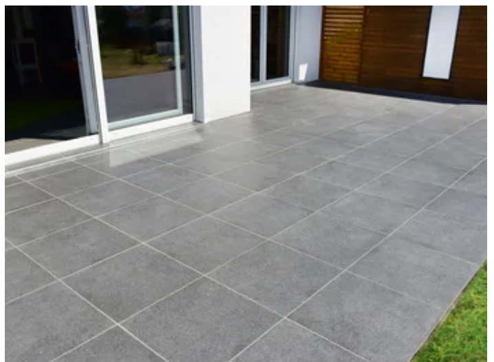
Die verfugte Oberfläche ist nach 24 Stunden begehbar.
