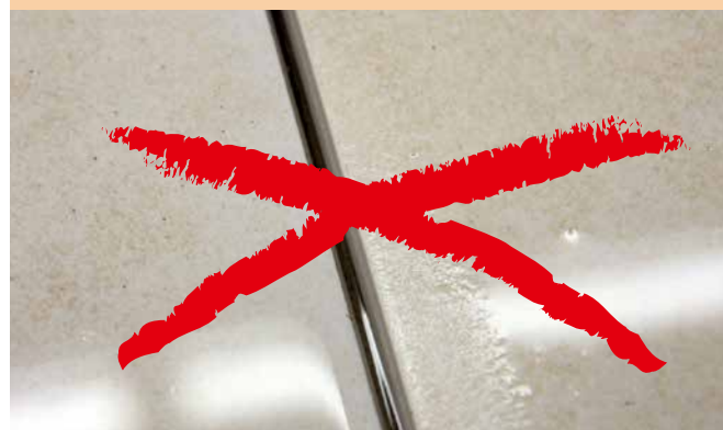
Übermäßiges Vornässen des Fliesenbelags: Ansammlung von Wasser in der Fuge führt zu Fleckenbildung und Festigkeitsverlust in der erhärtenden Fuge.
