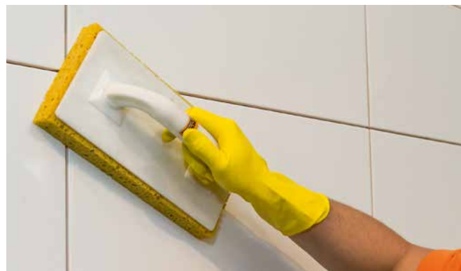
Ein Anfeuchten des Fliesenbelags mit einem feuchten Schwammbrett erleichtert den Einfugprozess.
