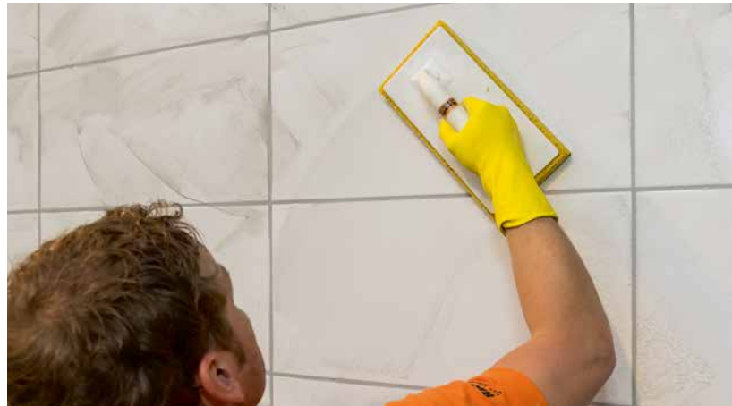
Vorwaschen eines frisch verfugten Fliesenbelags.
