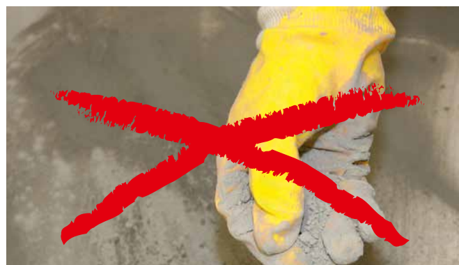
Pudern eines frisch verfugten Fliesenbelags führt zu einem ungleichmäßigen Fugenbild.
