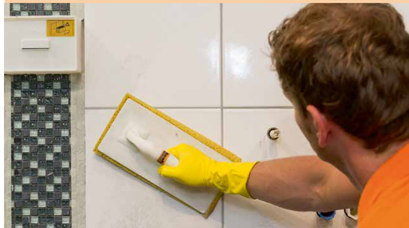
Abwaschen eines frisch verfugten Fliesenbelags.
