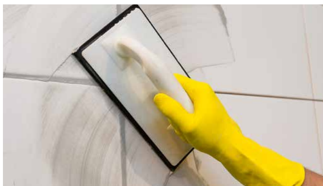
Verfugen von geschnittenen Fliesen mit Epoxifugbrett, mit hartem Feingummibelag.
