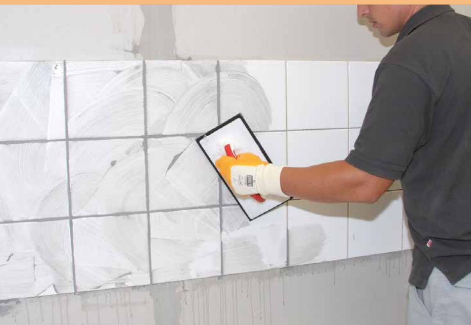
Verfugung eines Fliesenspiegels mit Racofix® Multi-Flexfuge Plus
