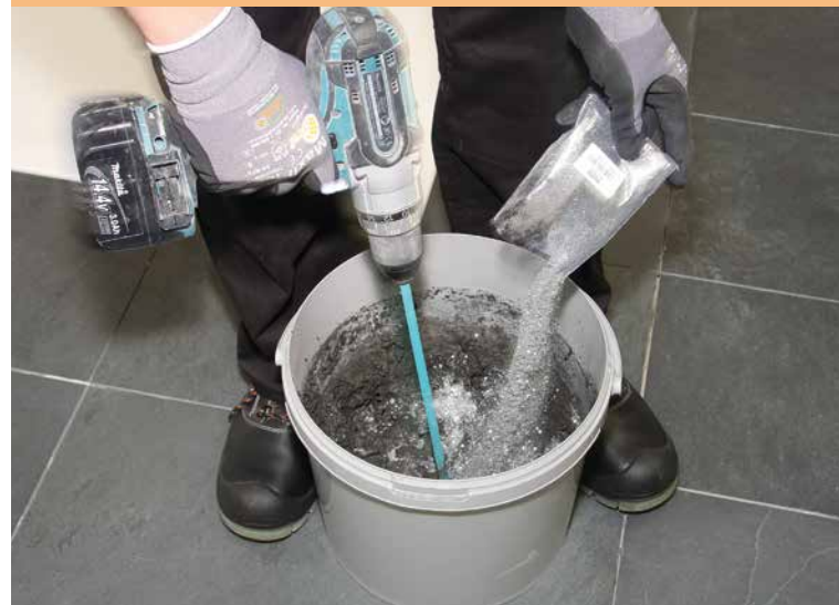
Besonders wichtig: das maschinelle Anrühren mit einem Rührquirl, um einen homogenen und sämigen Fugenmörtel zu erzielen (Hier mit Glitteranwendung).
