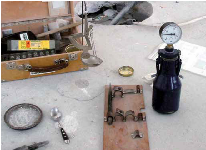
Vor der Verlegung der Großformatplatten ist der Estrich mit dem CM-Gerät auf seine Restfeuchte zu überprüfen.
