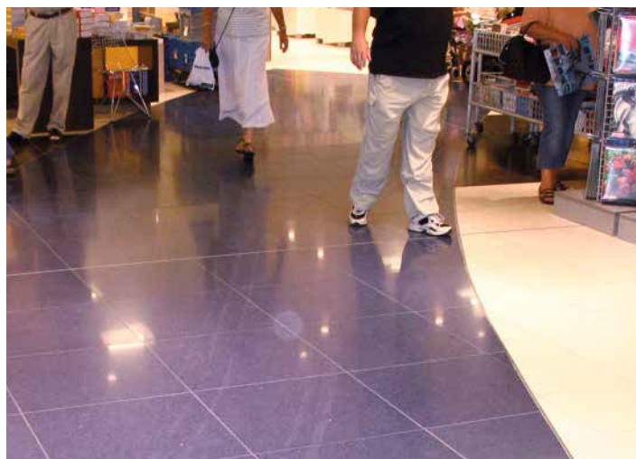
Kunstharzgebundene Großformatplatten nach entsprechender Untergrundvorbereitung optimal verlegt.
