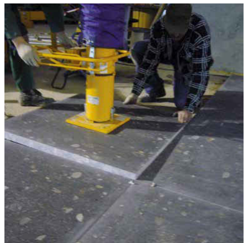
Maschinelles Versetzen der schweren Platten.
