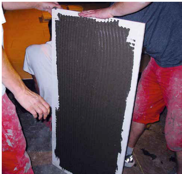
Kontaktpachtelung auf der Rückseite einer Großformatplatte.
