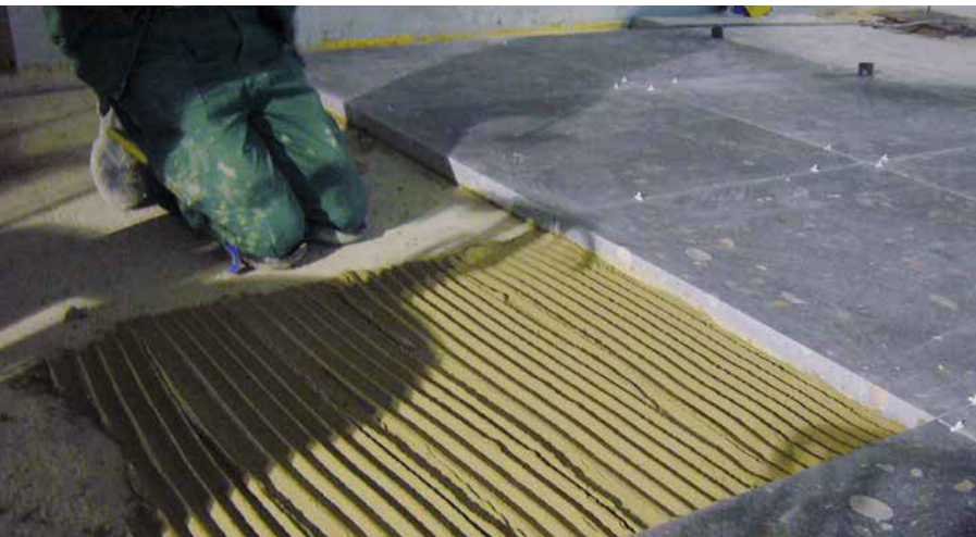
Racofix® Naturstein-Verlegemörtel vorbereitet zur Aufnahme sehr schwerer großformatiger Betonwerksteinplatten.
