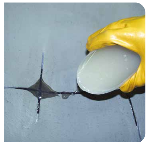
5 Estrichrisse werden mit Racofix® Rissnarz unter Verwendung von Querarmierungen (alle 25 cm) kraftschlüssig verschlossen.
