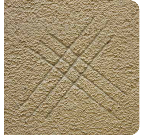
2 Die Oberflächenfestigkeit von Putzen/Estrichen wird mittels Gitterritzprüfung beurteilt. Die Ritzflanken dürfen insbesondere an den Kreuzungsstellen nicht ausbrechen.
