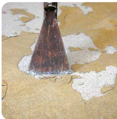
4 Alte Boden- und Wandbeläge (z.B. Teppichböden, lose Fliesenbeläge, alte Tapeten), nicht tragfähige Anstriche und Schmutzreste werden entfernt.
