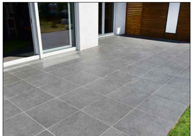
18 Die verfugte Oberfläche ist nach 24 Stunden begehbar.
