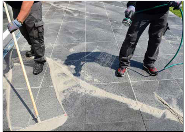
14 Die Fläche während des Fugens stets feucht halten.
