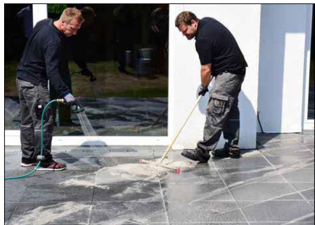
12 Material mit dem Wassersprühstrahl befeuchten, in eine geschmeidige Konsistenz bringen ...
