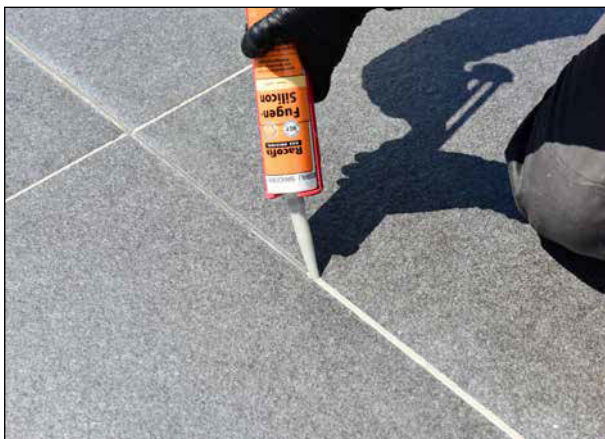
17 Anschluss- und Bewegungsfugen einbringen.
