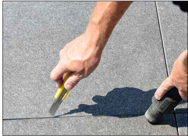
8 Die Fugen sind gründlich zu reinigen und von Rückständen zu befreien.
