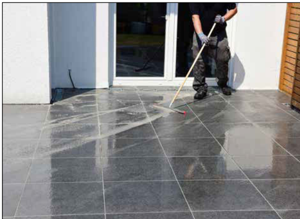
15 Überschüssigen Fugenmörtel abtragen ...
