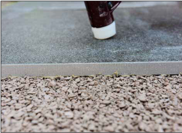
7 Die Platten einlegen und einklopfen.
