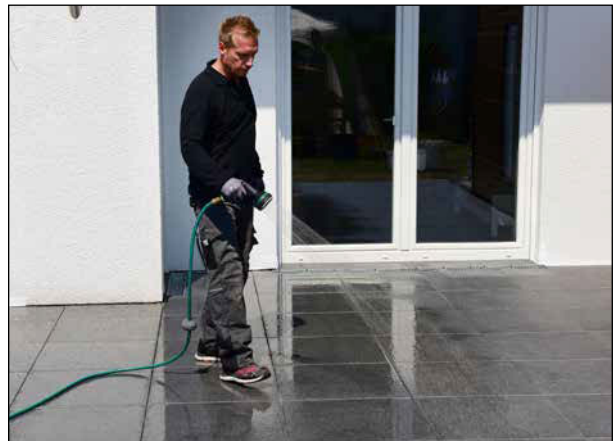
10 Vor der Verfugung muss die Fläche satt vorgehäst und feucht gehalten werden.
