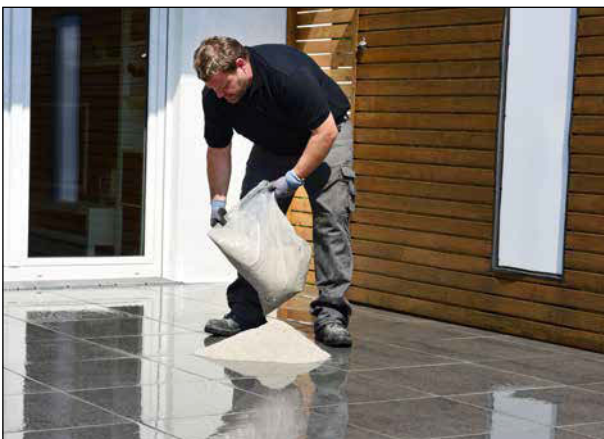
11 Racofix® Terrassen-Schlämmfuge auf den Belag ausschütten.
