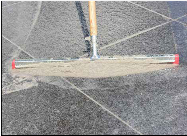
13 ... und mittels Gummischieber in die Fuge einbringen.
